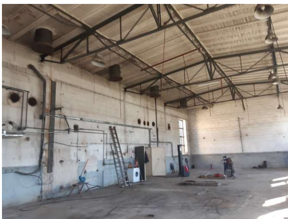
Konstrukcja dachu wymiennikowni
