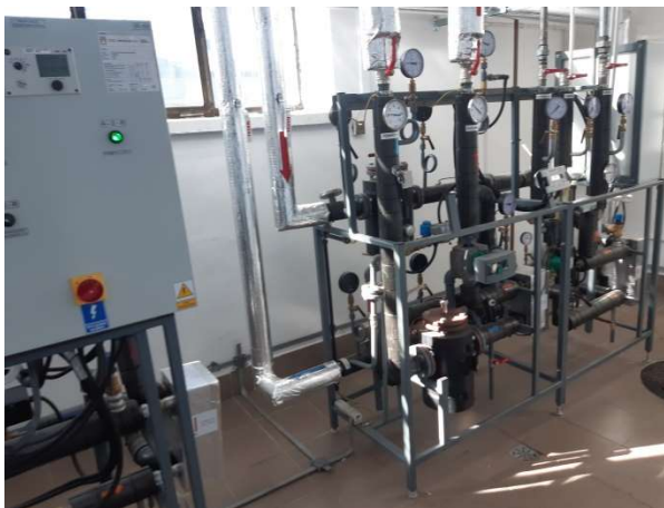
Węzeł cieplowniczy do sąsiedniego budynku – do wykorzystania
