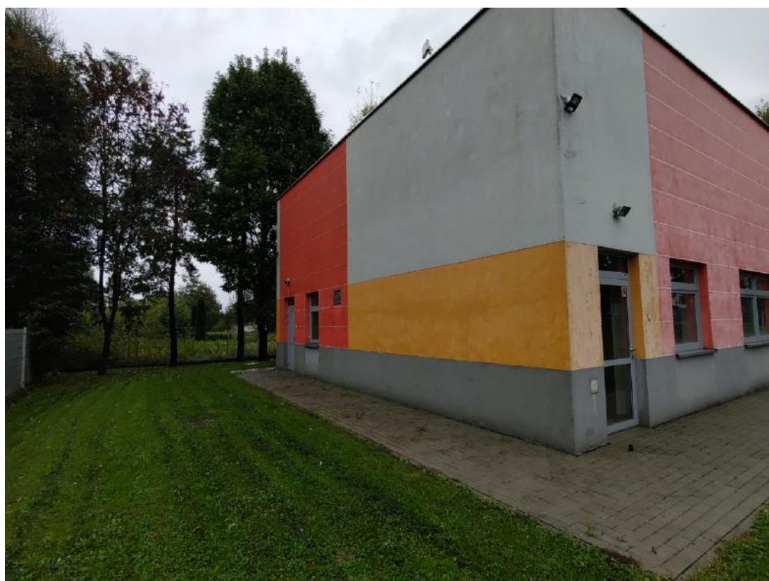
Tylna elewacja kotłowni GO (północna lub północno-zachodnia)
