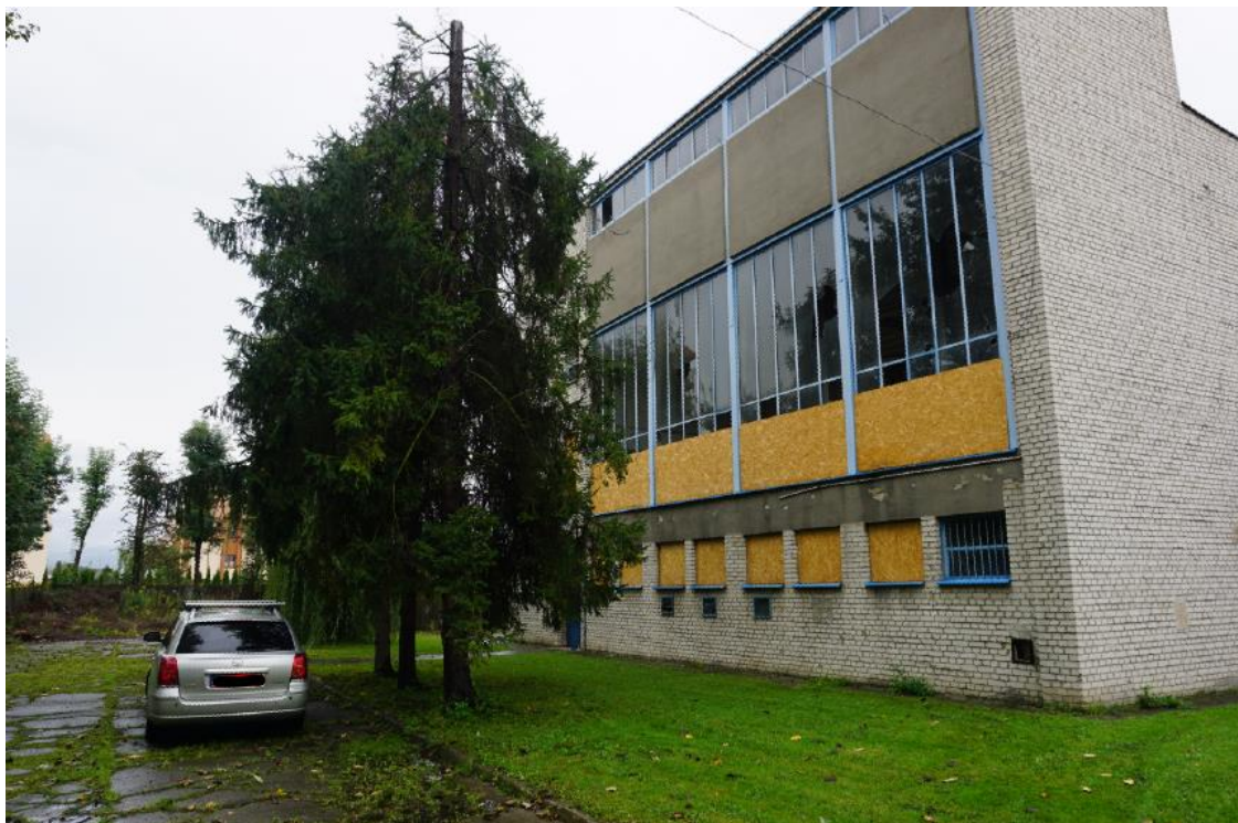
Widok na nieczynną kotłownię węglową od strony południowo-wschodniej
