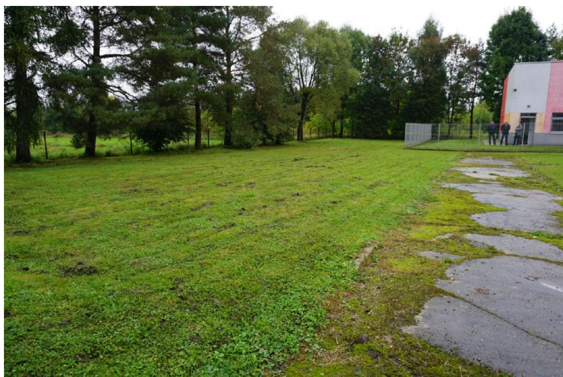
Widok na kotłownię GO (od strony zachodniej)
